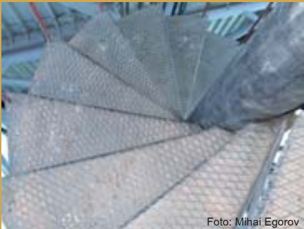
Spirala celor 216 scări ale farului.
