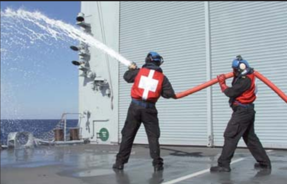
Verificarea instalației de stins incendiu cu spumă utilizată în cazul producerii unor incendii la apunarea elicopterului
