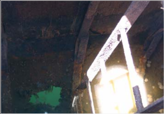
Găurile de apă sunt un pericol pentru navele aflate în Centrul de Colectare de la Mangalia.
