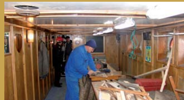
Carele ofițeri, unul din locurile unde s-a acționat în timpul reparațiilor.
