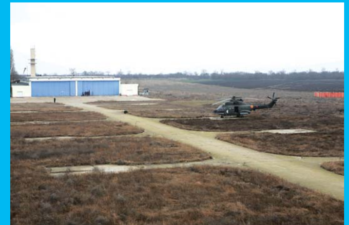
Pista aerodromului militar de la Tuzla. În fundal se observă hangarul renovat recent.
