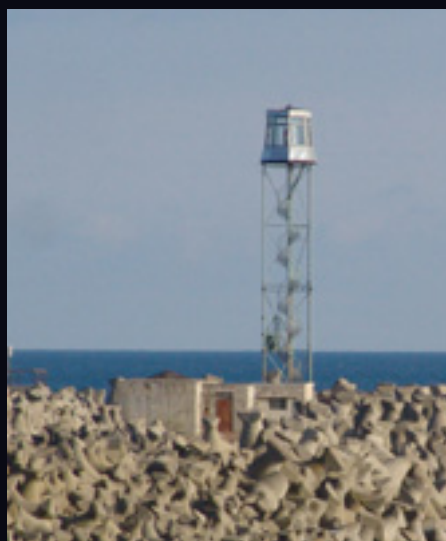
Farul Alb sau farul de larg din capătul digului portului Mangalia.
