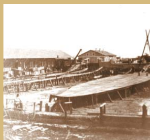
Fază de construcție a monitoarelor la Galați, 1907.
