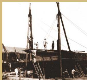
Fază de construcție a monitoarelor la Galați, 1907.
