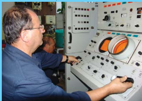
Secția I. Pcc Nicu Șarpe, montator, reglaj, depanare a atelierului mentenanță aparatură de automatică.
