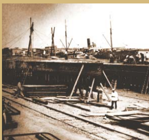
Fază de construcție a monitoarelor la Galați, 1907.
