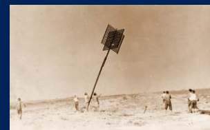
Instalarea catargelor de aliniament.
