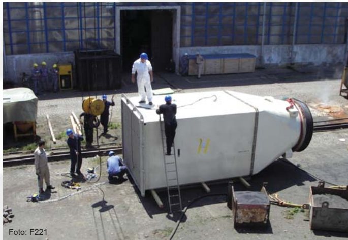
Demontare admisie la turbina „Olympus”
