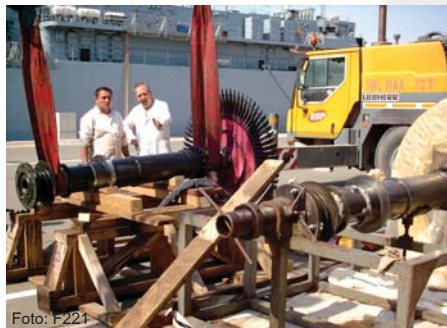
Foto: F221 Demontarea turbinei de putere „Olympus” sub atenția șefului Resurselor din SMFN, contraamiralul de flotilă Dan Popescu
