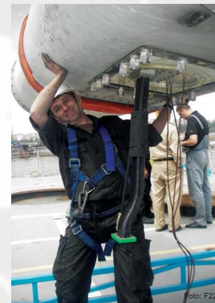
Activități de mentenanță la o antenă radar
