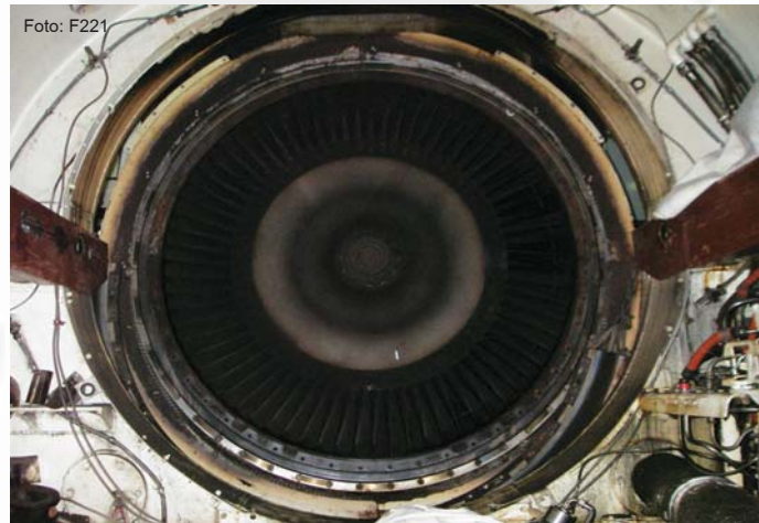
Demontare turbina de putere „Olympus”
