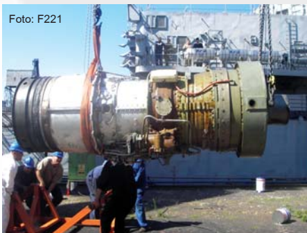
Foto: F221 Demontarea generatorului de gaze al turbinei „Olympus”
