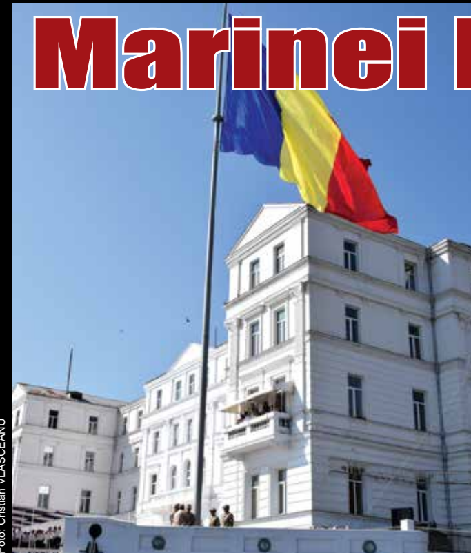
Ridicarea pavilionului la Comandamentul Flotei.
