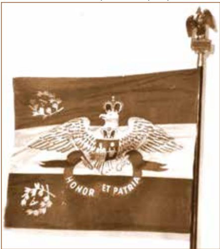
Pavilionul Corpului Flotilei. (1860)
