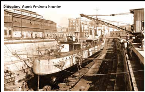
Distrușorul Regele Ferdinand în șantier.
