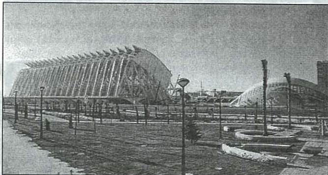
Parcul civic, în construcție, din albia bătrânului și intempestivului Turia
