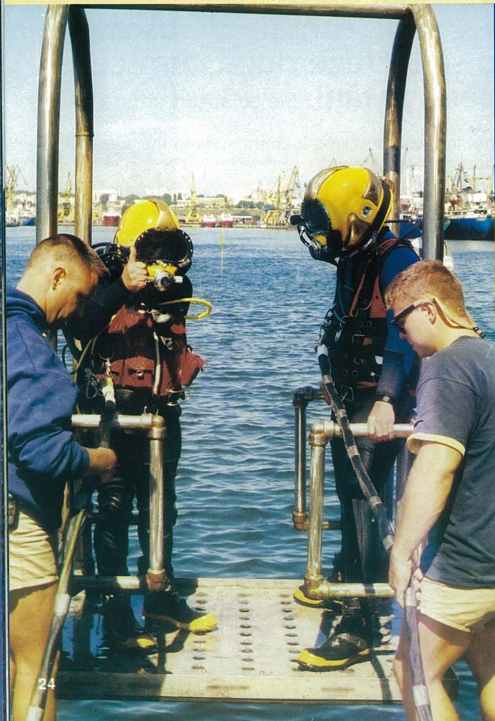
▲ MM2 Constantin Grosu și MM2 Mircea Constantin au executat în septembrie 2000 o intervenție pentru remedierea unei defecțiuni apărute la sistemul de încărcare-descărcare a combustibilului nuclear de la Unitatea 1 a Centralei Nuclearo-Electricre de la Cernavodă. Apa din bazinul unde a avut loc scufundarea este considerată „slab contaminată“.
